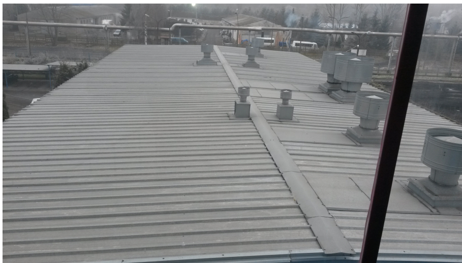
ZDJ. 1 – [DACH PŁASKI BUDYNKU NALEŻĄCEGO DO ELEKTROCIEPŁOWNI]
